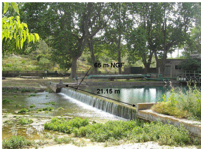
Vue du déversoir de la source du Lez
